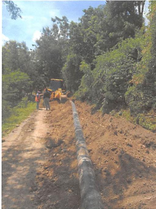
*Ilustración 1: Colocación De tuberías Acero 8"*
