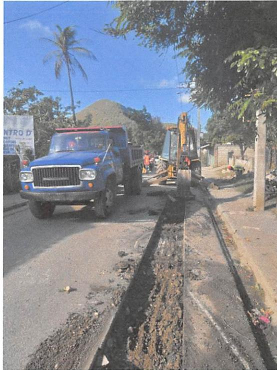
*Ilustración 1: Equipo realizando Remoción de Asfalto – Rio Arriba*
