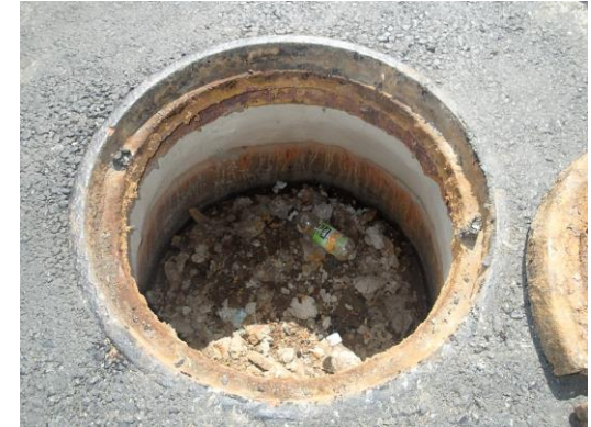
Limpieza de la red
