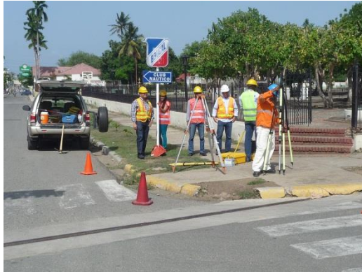
Levantamientos topográficos (octubre 2012)
