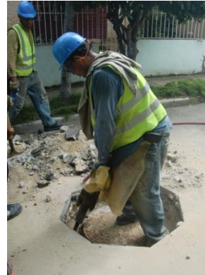
Puesta a nivel de las tapaderas (inicio febrero 2014)
