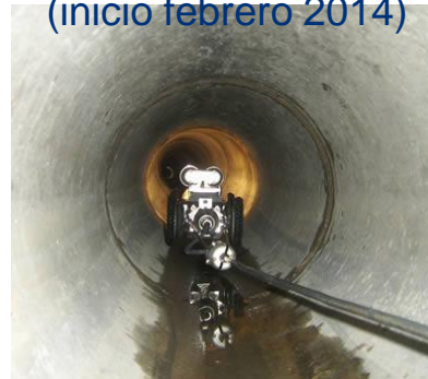
Inspección video de las tuberías
