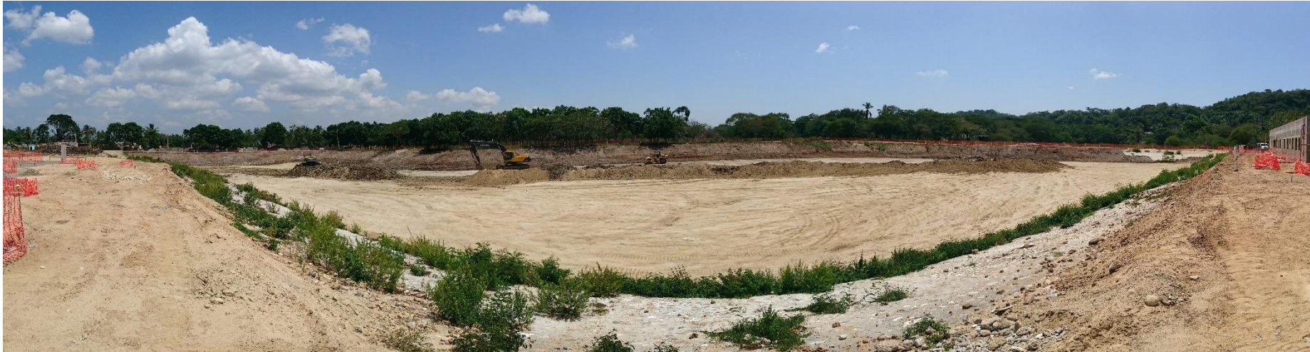
Nivelacion de laguna y construccion de cerco perimetral en la PTAR-SC. Agosto 2015
