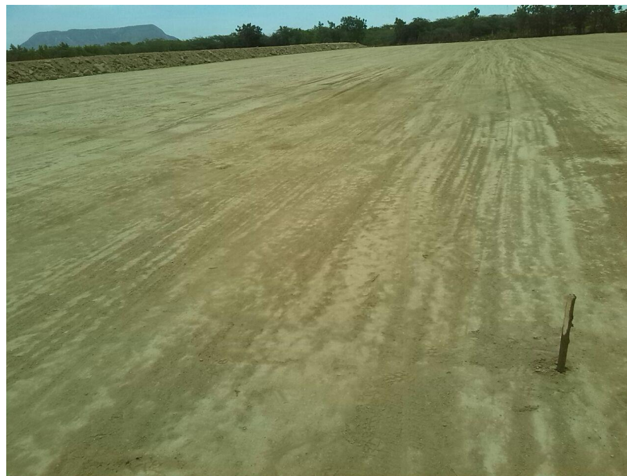
Terminacion de Laguna 1A
