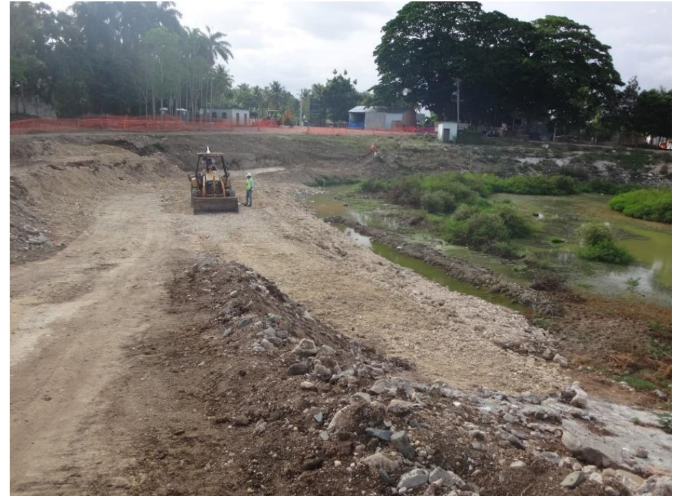
Relleno de Laguna existente. Planta de Tratamiento Aguas Negras San Cristobal Mayo 2015
