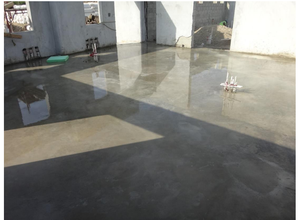
Hormigonado de pisos oficinas campamento Montecristi / Villa Vasquez Mayo 2015
