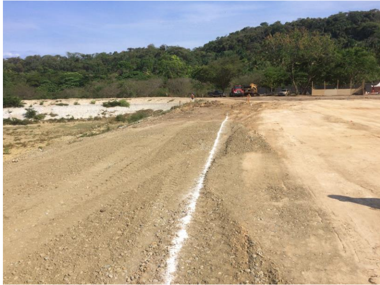
Nivelacion de terreno para Campamento en Planta de Tratamiento de Aguas Residuales en San Cristobal Mayo 2015
