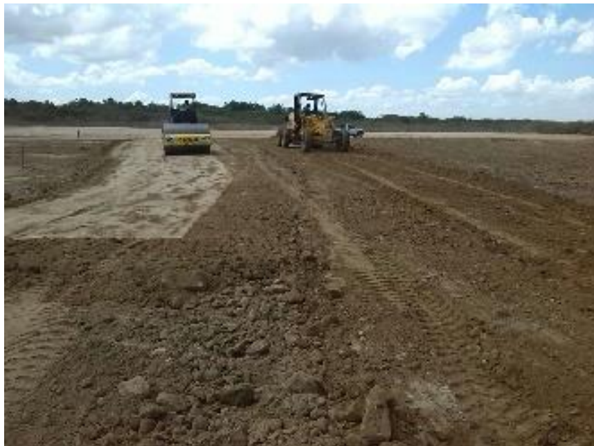
Trabajos de compactacion y relleno de drenaje Planta de Tratamiento de Aguas Negras Montecristi Mayo 2015
