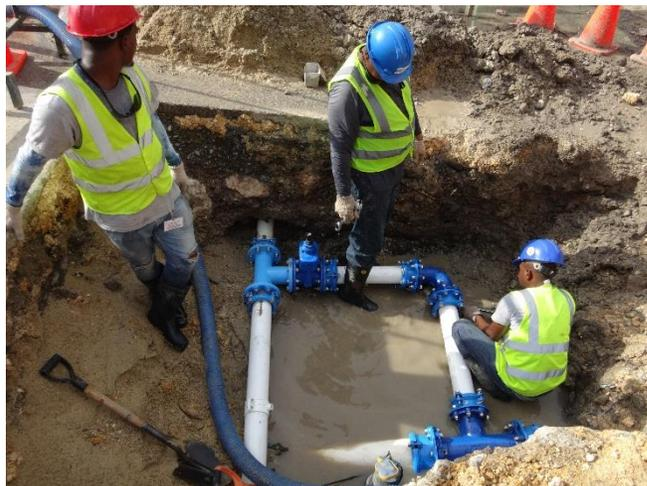
Reparación e instalación de nuevas tuberías y válvulas en las redes de aguas servidas del municipio de San Pedro de Macorís.
