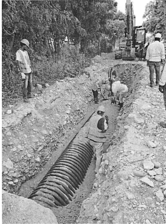
*Ilustración 1: Colocación Tubería 30" Polietileno Corrugado.*
