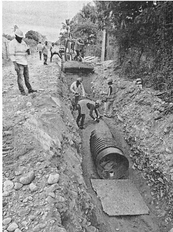
*Ilustración 2: Colocación Arena de Acuña Tubería 30" Polietileno Corrugado*
