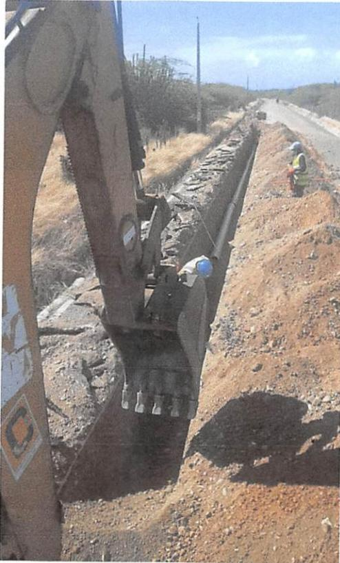
*Ilustración 1: Colocación de Tuberías PVC 6" – Las Tablas*
