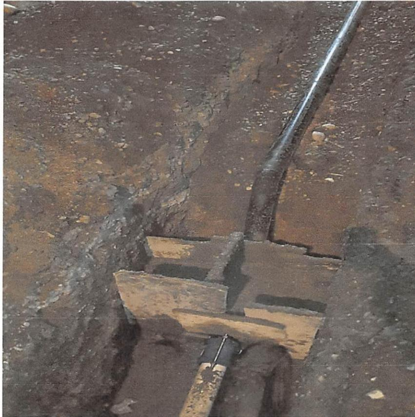
*Ilustración 1: Colocación Cruce de Acero Tub. 3"*
