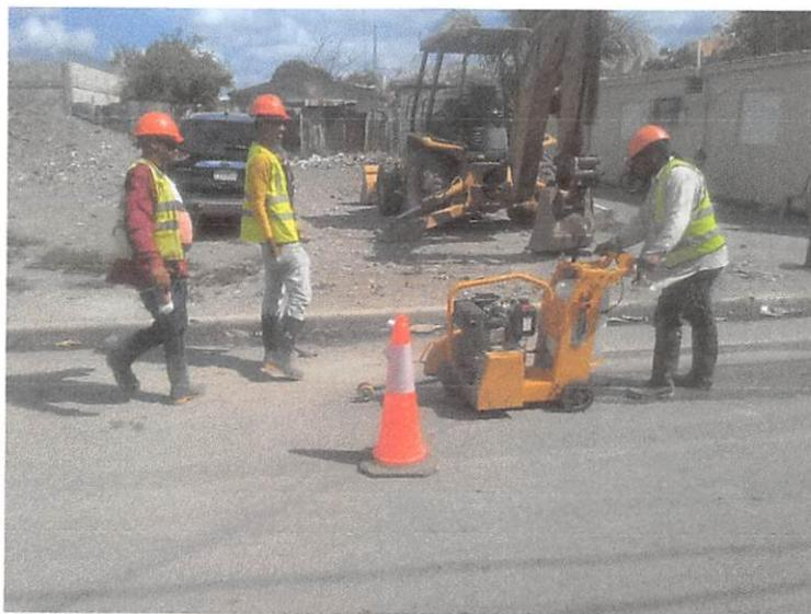
*Ilustración 2: Corte de Asfalto*
