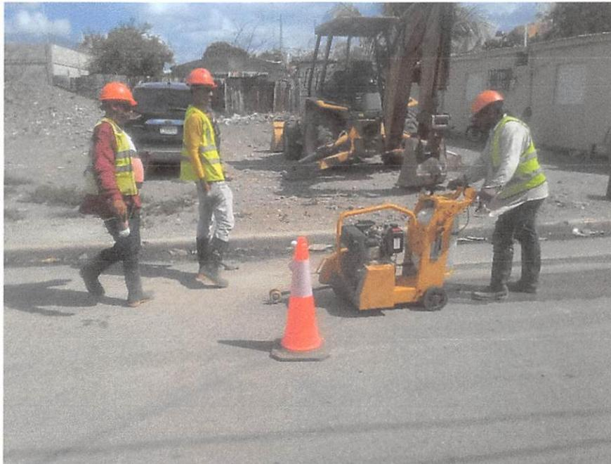
*Ilustración 2: Corte de Asfalto*
