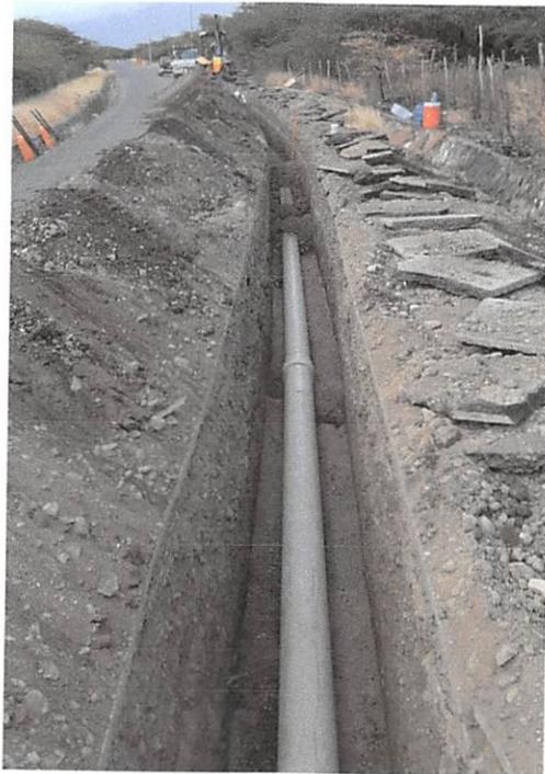
*Ilustración 2: Colocación de Tuberías PVC 6" – Las Tablas*
