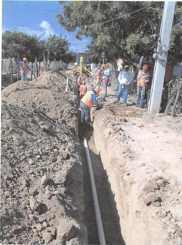
*Ilustración 1: Colocación Tuberías 4" PVC SDR26*
