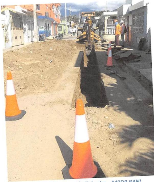
*Ilustración 1: Colocación Tuberías – MRDB BANI*
