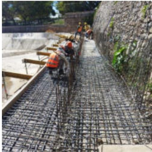
Armado de encofrado y Acero de Vuelo de ciclovía debajo de puente av. 27 de febrero.
