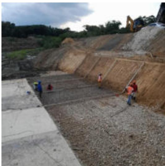
colocación de Acero de  $\frac{1}{2}$  a 20cm A.C y A.D.
