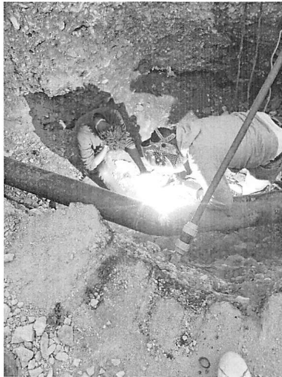
Ilustración 2: Colocación De Piezas tuberías 8" Acero – Sector Limonal
