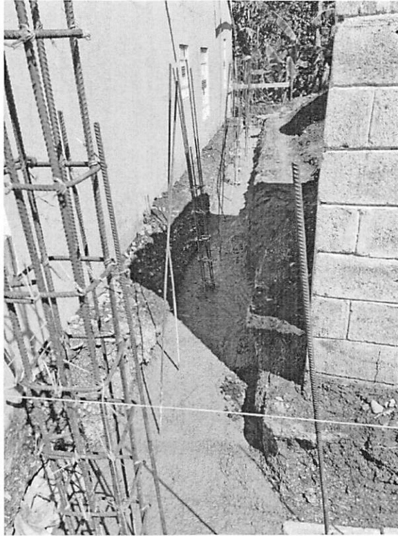
Ilustración 1: Hormigonado zapata verja perimetral depósito metálico
