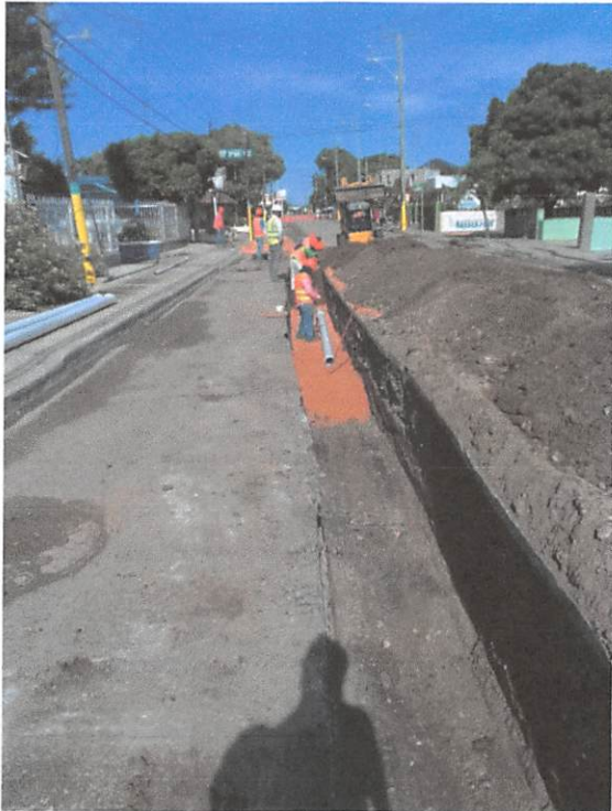
Ilustración 2: Colocación de Tuberías – Rio Arriba
