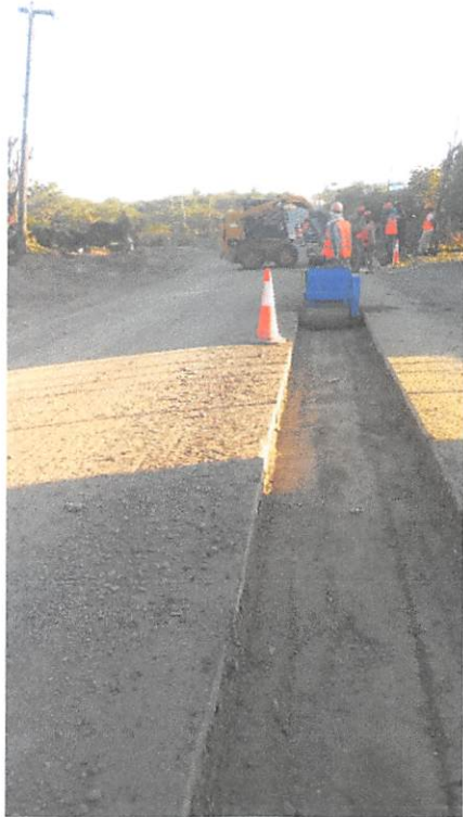
Ilustración 1: Compactación de Zanja – Rio Arriba
