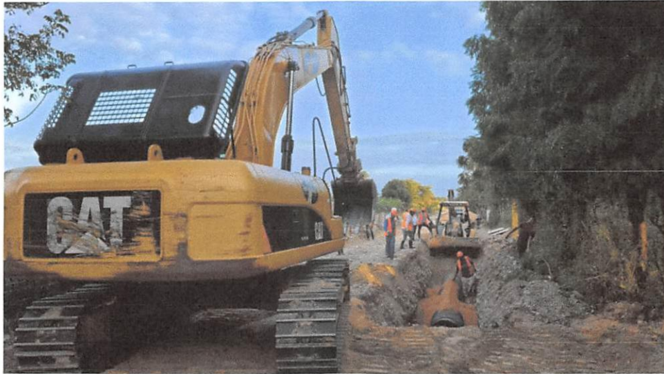
Ilustración 1: Colocación Tubería 30" Polietileno Corrugado.
