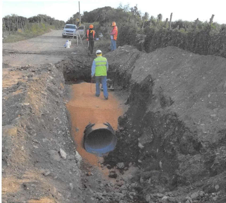
Ilustración 2: Colocación Arena de Acuña Tubería 30" Polietileno Corrugado
