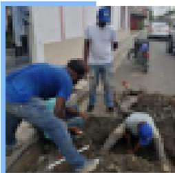
Técnicos de la Dirección de Operaciones en Peravia realizó un amplio operativo de corrección de averías en el casco urbano del municipio Bari. Una siete fugas de agua en redes de distribución de 1/2, 3/4, 1 y 2 pulgadas, fueron reparadas de manera simultánea.
