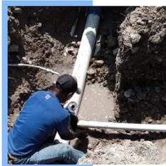
Un equipo técnico de la Dirección de Operaciones en Azua instaló la línea de distribución de más de 70 metros lineales de tubería de dos pulgadas en PVC, en la parte alta del sector Resolí en el municipio cabecera.
