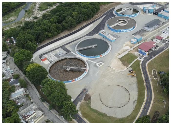
Detalló que la obra posee un sistema de gravedad-bombeo, para tratar 306 litros por segundo, el cual está compuesto por una cámara de recepción con aliviadero, un pozo de gruesos, un pozo de bombeo de agua residual bruta con cuatro bombas sumergibles, así como tres canales de desbaste fino: dos con tamices automáticos y uno con tamiz manual.
