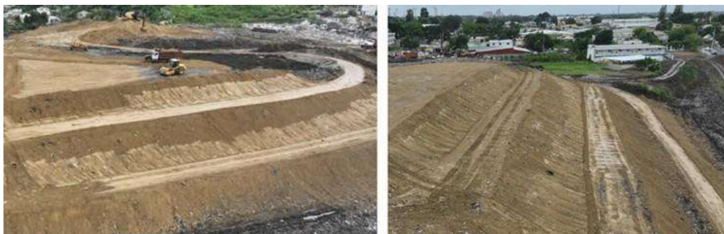
Foto 9.2. Actividad de compactación y relleno durante el cierre del Vertedero de Moca
