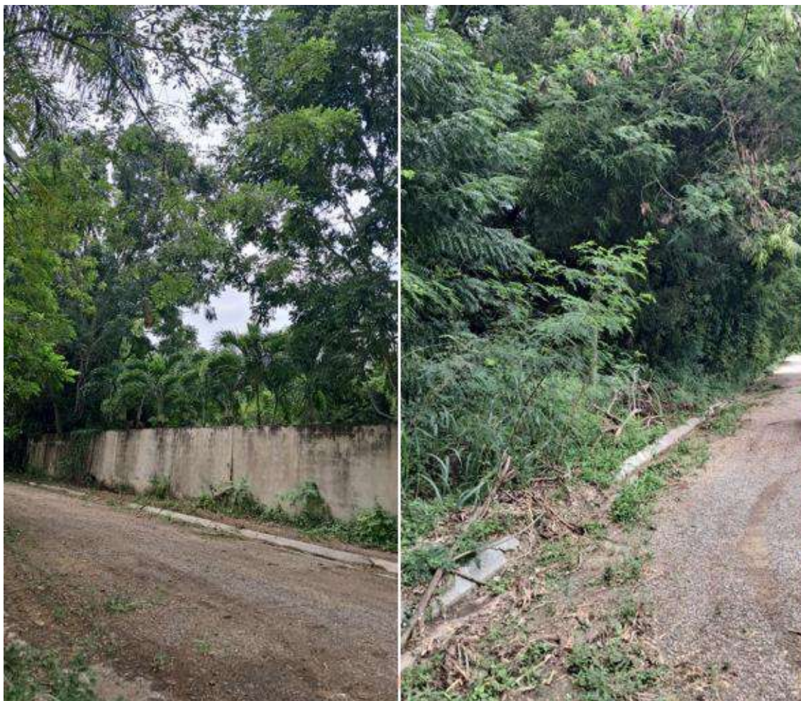
Foto 6.10. Estación de bombeo EBAR con potencialidad para ser rehabilitada con densa cobertura arbórea de algunos árboles de Cedro
