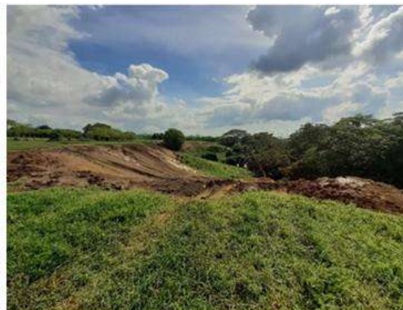
Vista general del lugar de vertido
