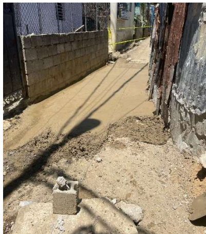
Recomposición de hormigón
