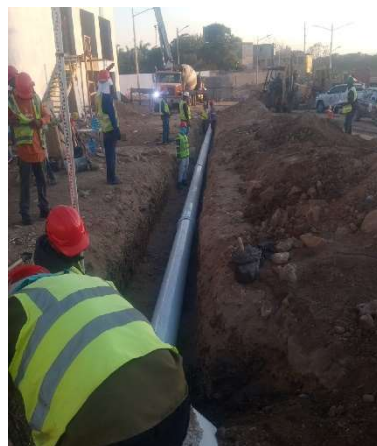
Colocación de tubería
