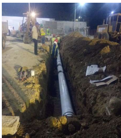
Colocación de tubería
