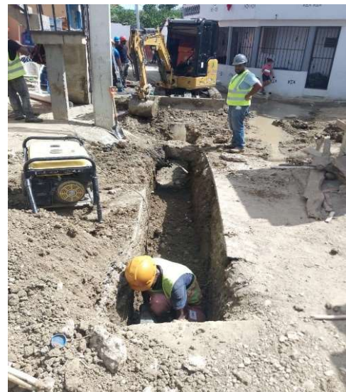
Excavación con equipo
