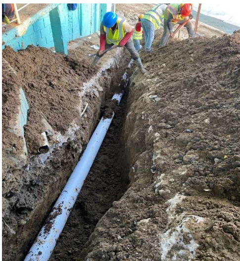
Colocación de tubería
