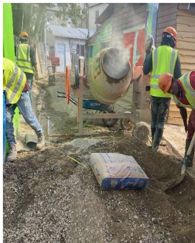
Recomposición de hormigón
