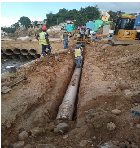
Instalación de tubería de agua residual
