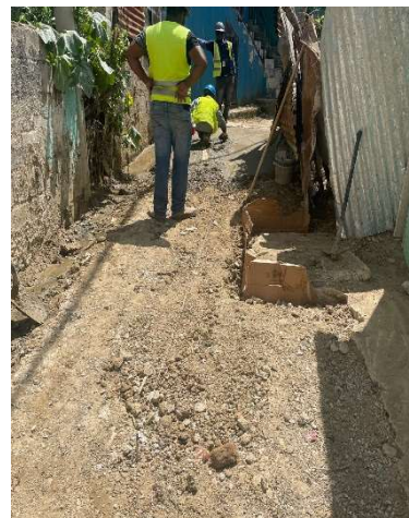
Recomposición de hormigón
