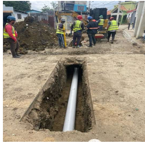
Colocacion de tubería de agua residual
