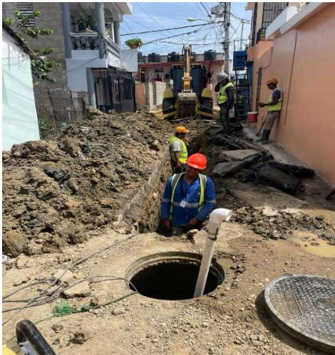
Excavación con equipo
