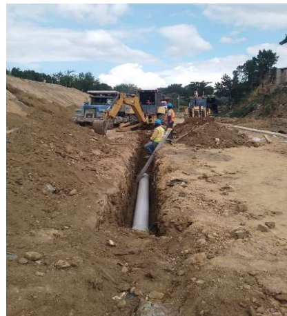
Colocación de tubería
