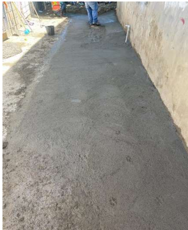
Recomposición de hormigón
