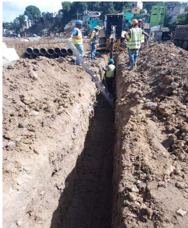
Excavación para tuberías de agua residual
