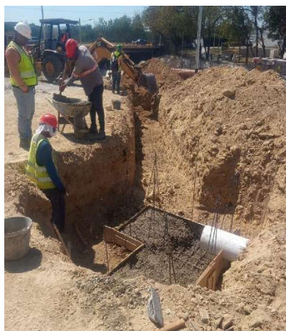
Excavación y colocación de imbornal
