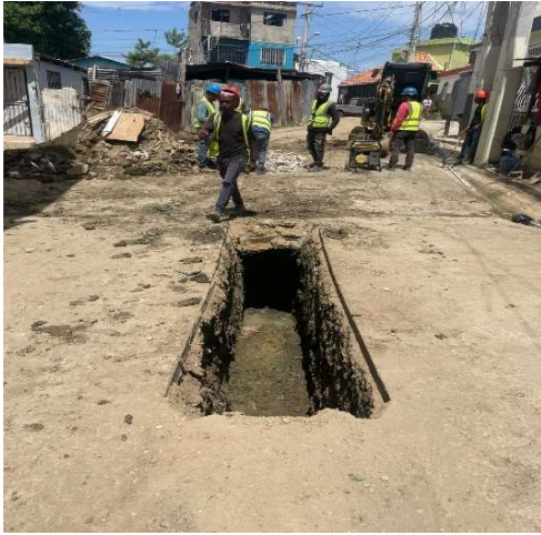
Excavación con equipo
