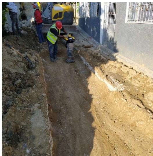
Compactación de material de relleno
