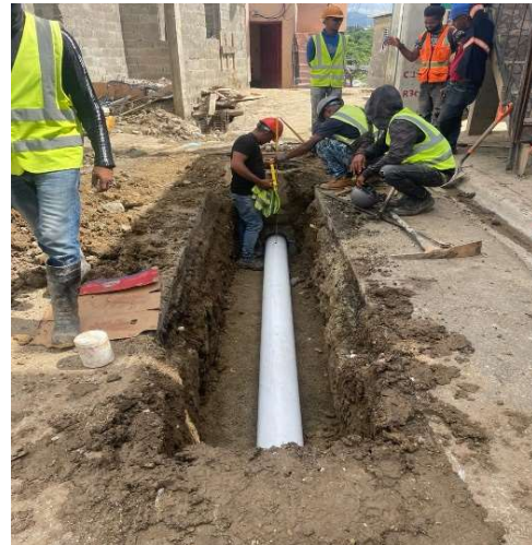
Colocación de tubería de agua potable
