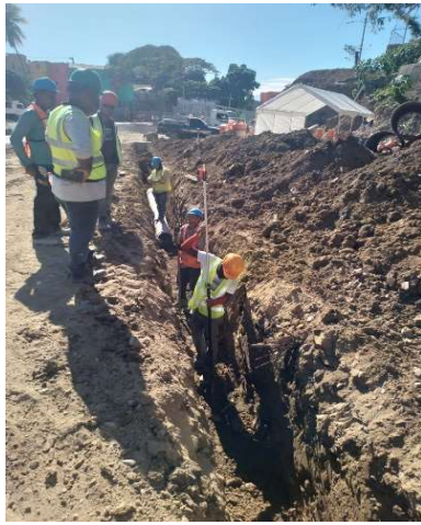
Replanteo y control topográfico
