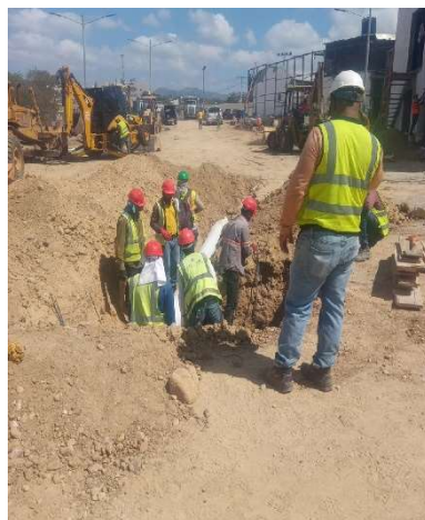
Colocación de tubería
