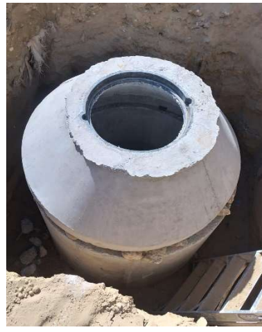
Excavación y colocación de registro
