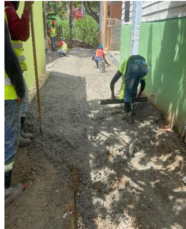
Recomposición de hormigón
