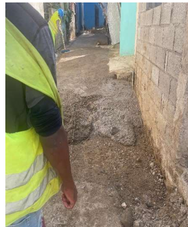
Recomposición de hormigón
