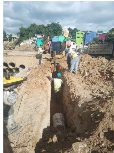
regularización de zanja
