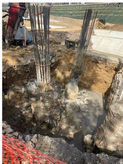
Construcción de registro condominal
