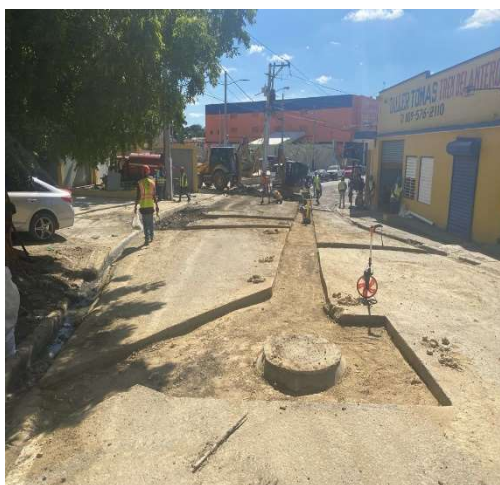
Corte de asfalto con equipo
