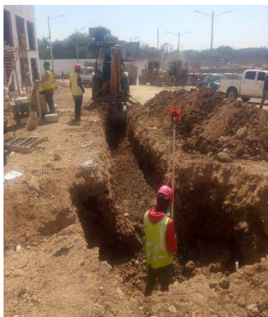
Excavación y replanteo topográfico
