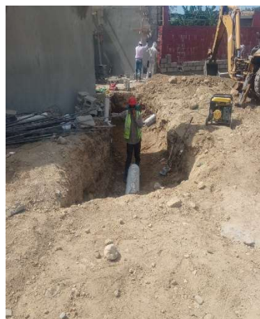
Colocación de tubería
