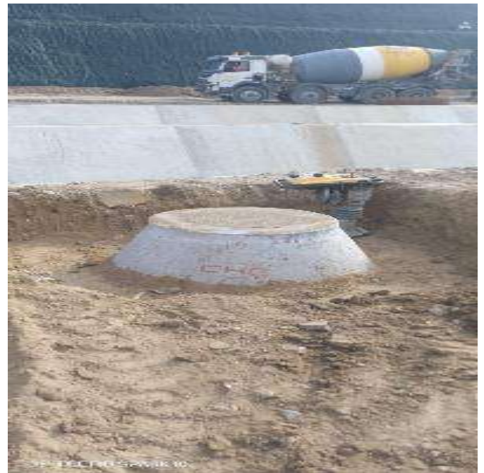
Colocación registro Prefabricado
