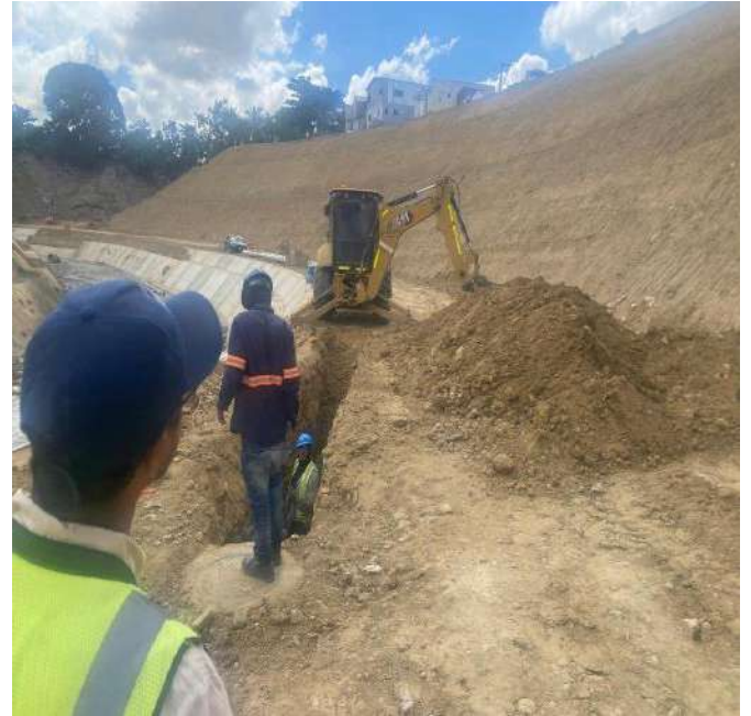
Tuberia de 12" pvc colectora
