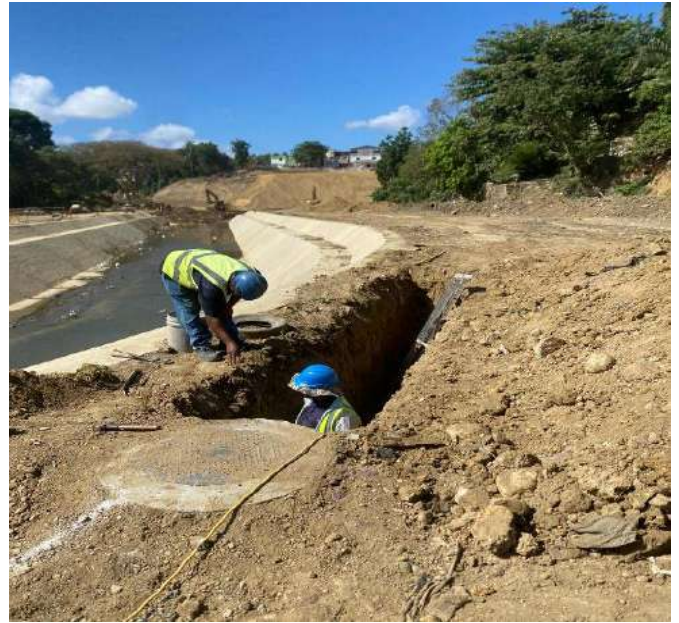
Colocación de registro prefabricados
