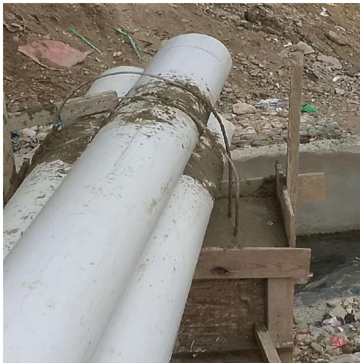
Tuberia de 16" pvc solución pluvial calle 15
