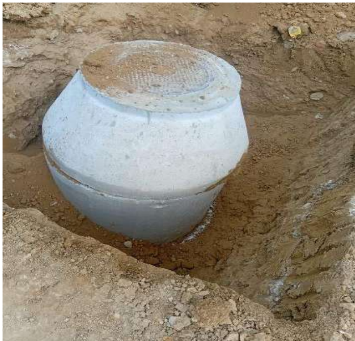
Colocacion de registro prefabricados
