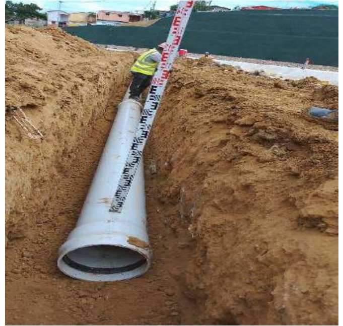
Tubería de 12" pvc
