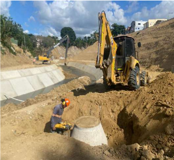
Colocacion de registro prefabricados
