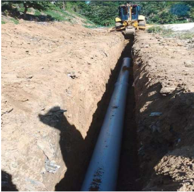
Tubería de 16 " pvc
