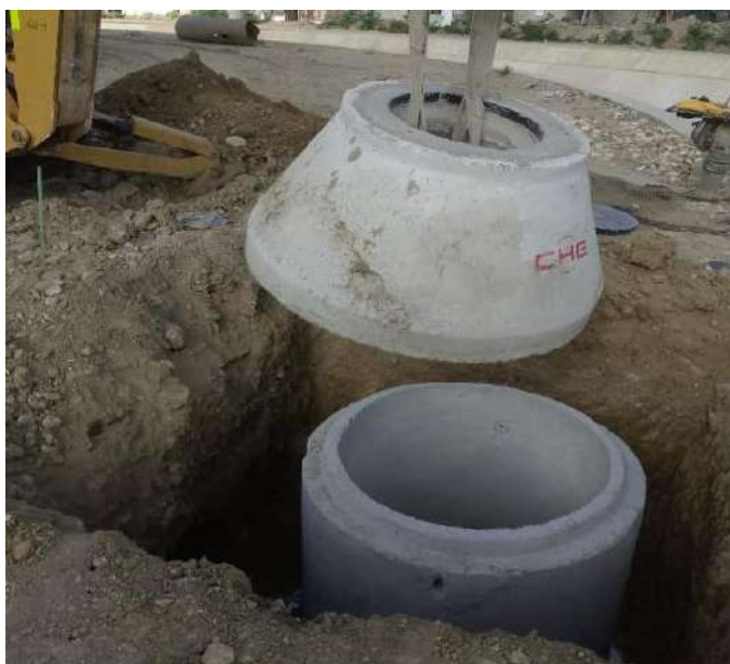
Colocación resisto interconexión ciruelito – bartola
