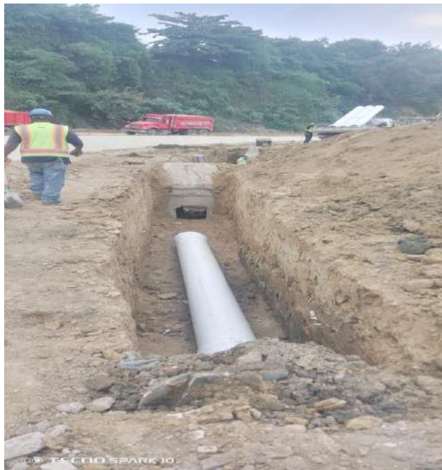
Colocacion de tuberia de 12" pvc colectora
