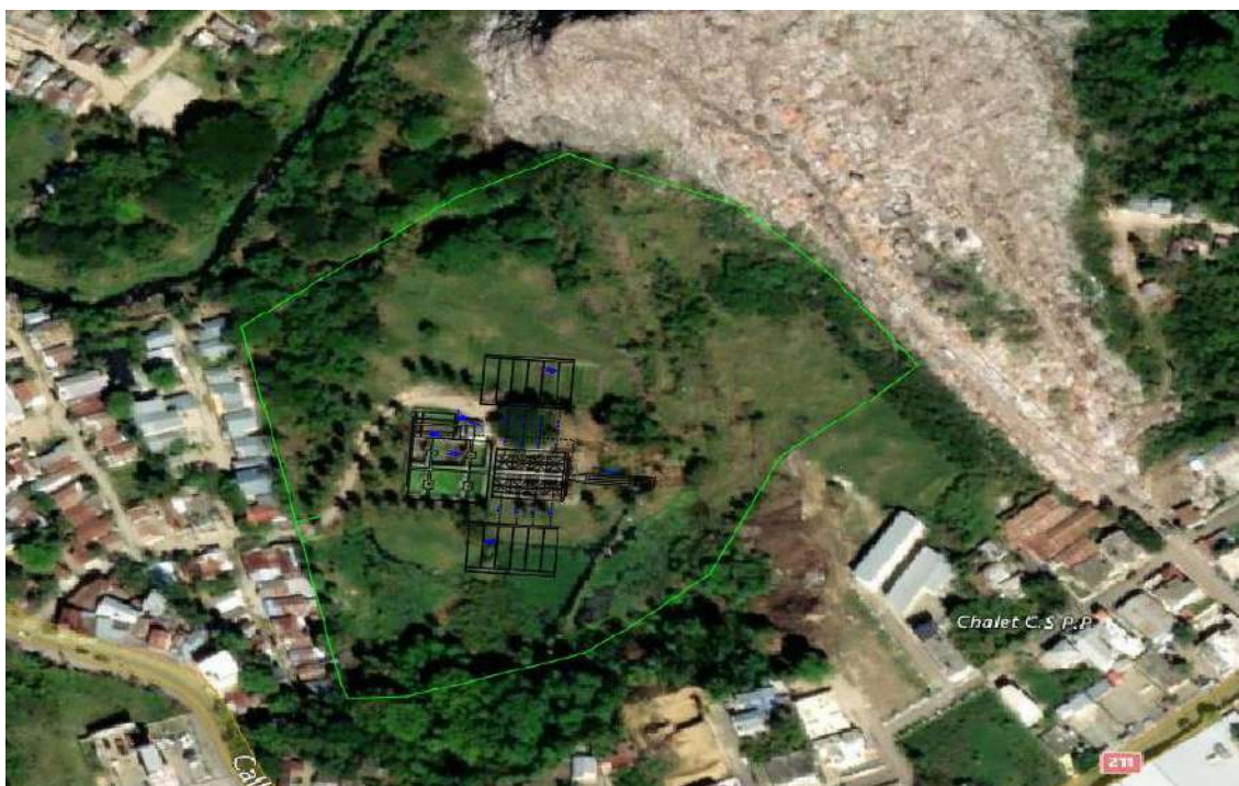
Figura 3.17. Zona PTAR #1 Las Colinas
