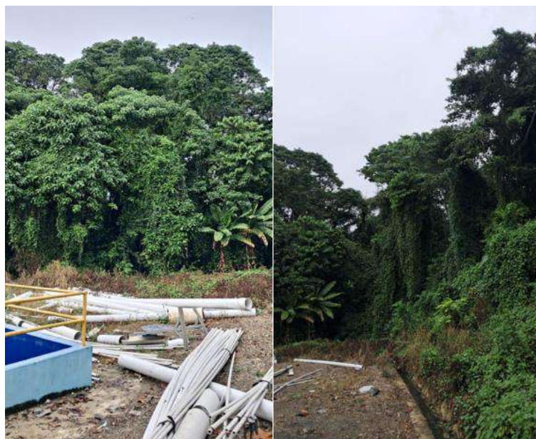
Foto 6.22. PTAR, La vegetación está muy descontrolada, aquí se visualiza como las lianas arropa a los árboles
