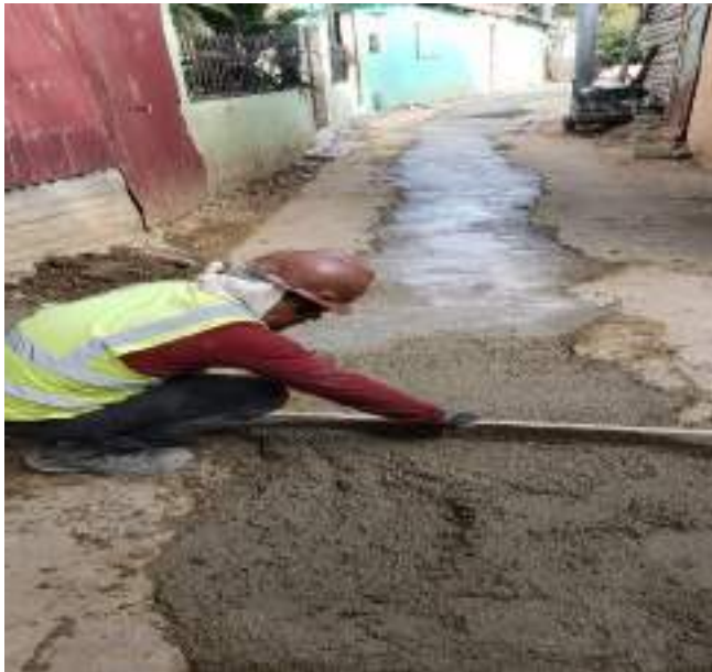
Canalización de aguas residuales los Santos zaidas
