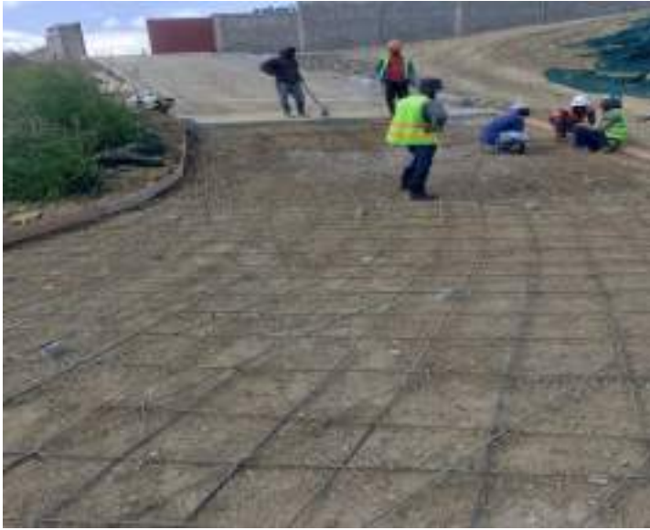
rampa los entrada los solares
