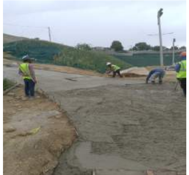
rampa los entrada los solares
