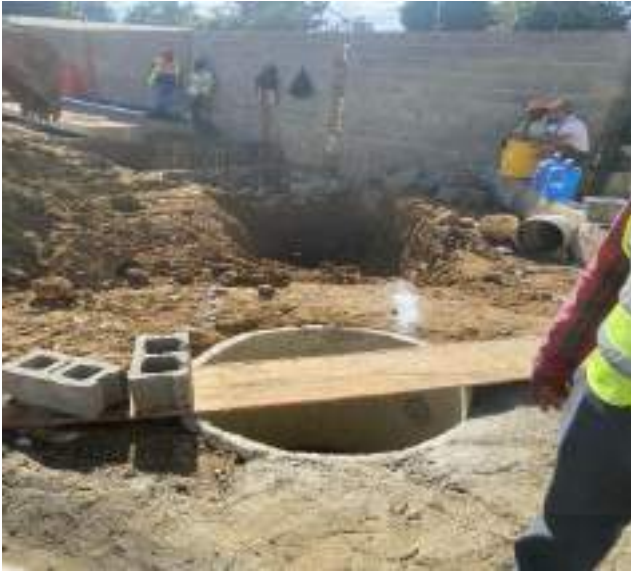
Construcción imbornal 2 parrilla
