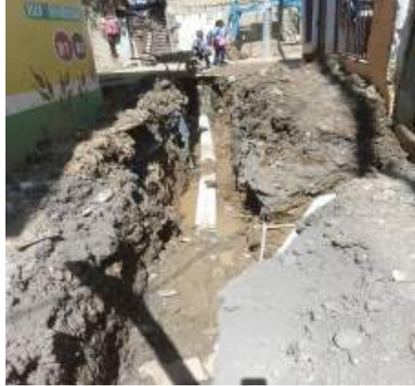
colocación tubería de 8 los ciruelito
